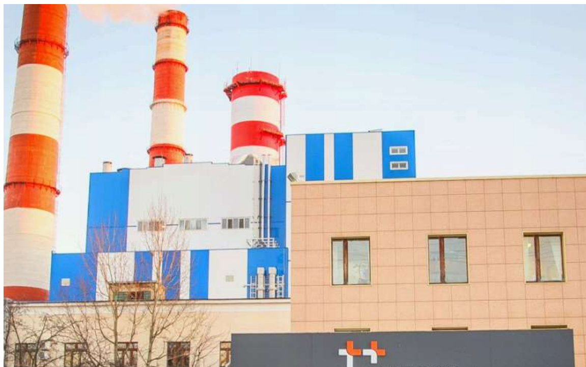
Рисунок 6 – Общий вид источника комбинированной выработки – ИвТЭЦ-3
