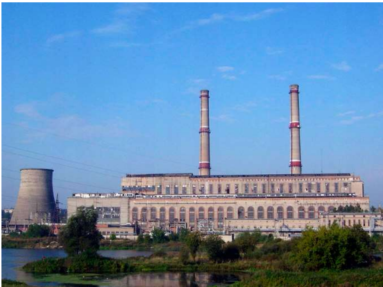
Рисунок 4 – Общий вид источника комбинированной выработки – ИвТЭЦ-2
