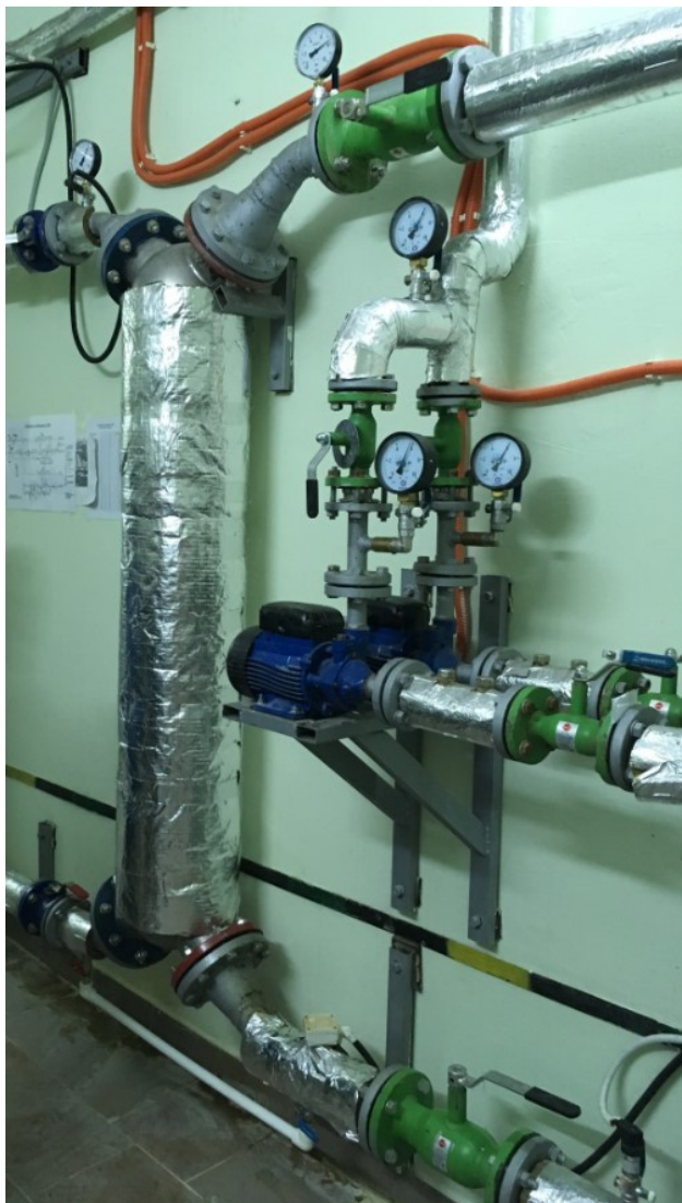
Рисунок 3.8 – Элементы схемы ИТП на базе кожухотрубных теплообменных аппаратов
