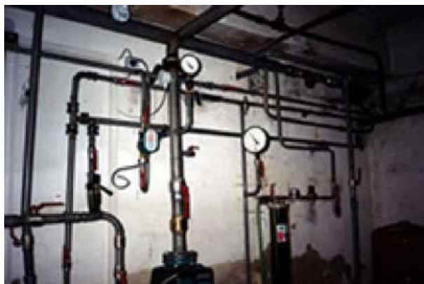
Рисунок 3.11 – Расположение ИТП
