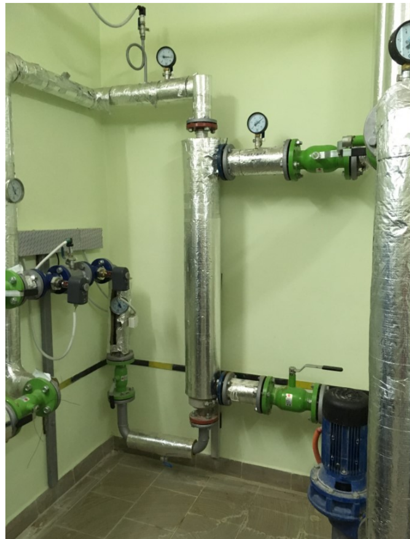
Рисунок 3.8 – Элементы схемы ИТП на базе кожухотрубных теплообменных аппаратов
